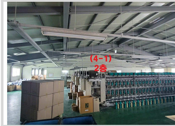
건물 (4-1) 2층 내부 전경
