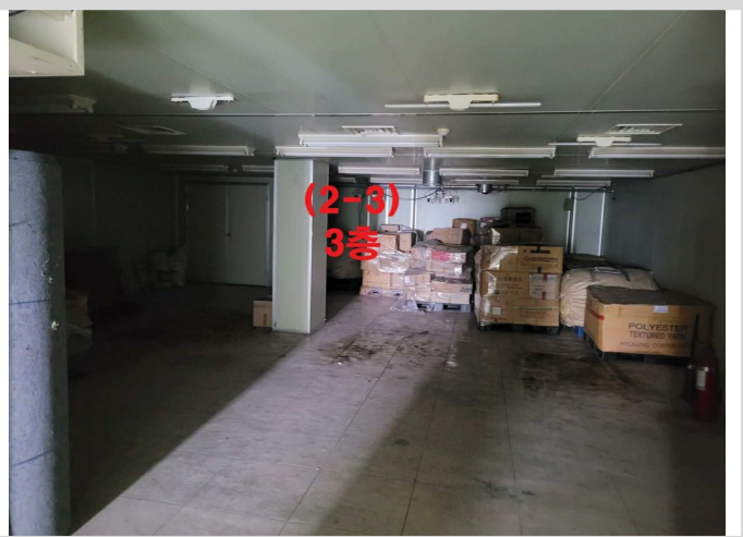
건물 (2-3) 3층 내부 전경
