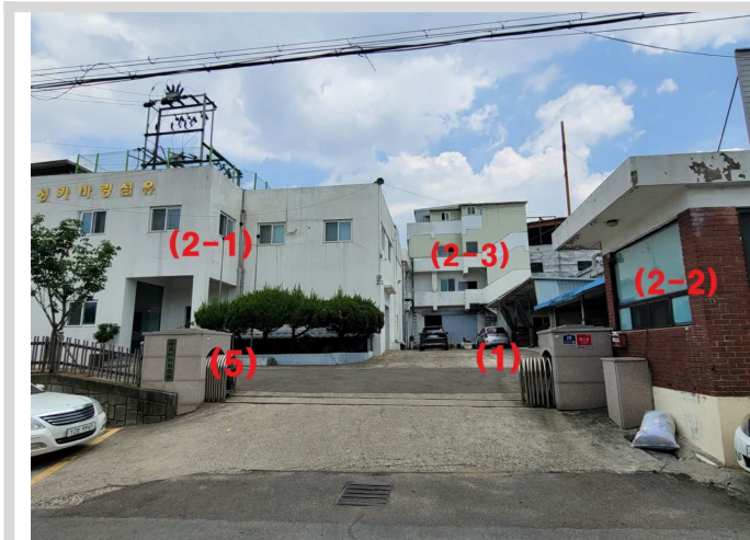
토지 (1),(5) 및 지상 건물 전경 (서측에서 촬영)
