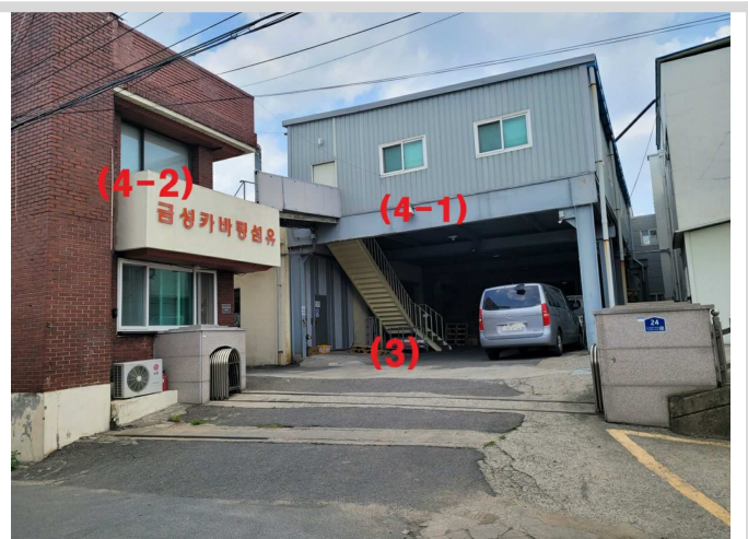
토지 (3) 및 지상 건물 전경 (서측에서 촬영)
