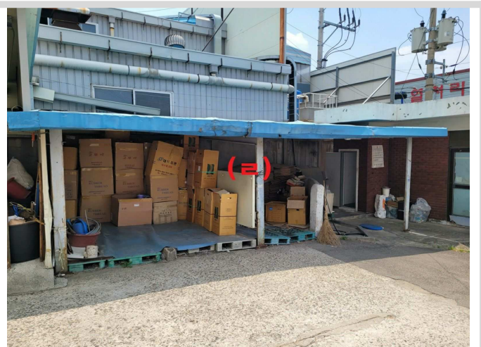
제시외건물 (ㄹ) 전경
