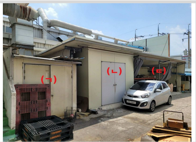
제시외건물 (ㄱ),(ㄴ),(ㄷ) 전경
