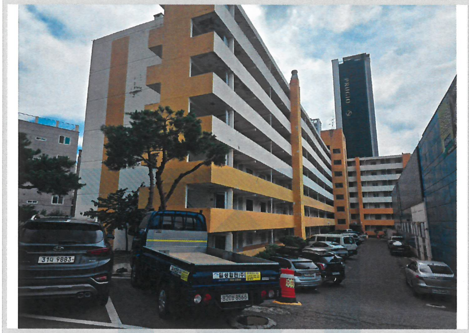
본건 전경(북동측에서 촬영)
