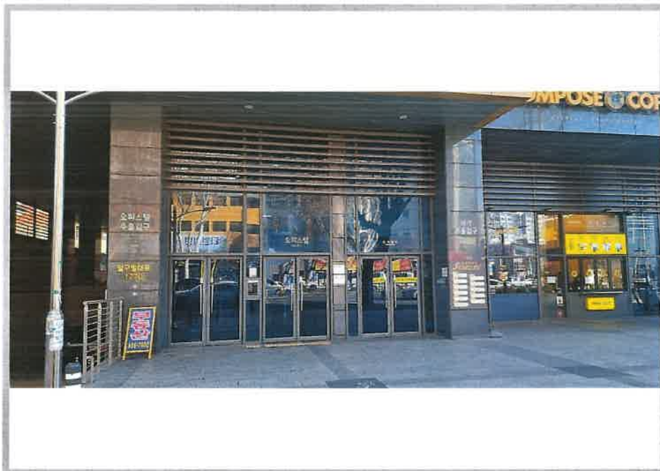
본건 오피스텔 1층 출입문
