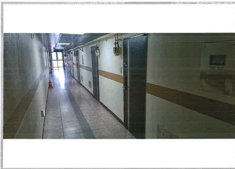
본건 오피스텔 5층 복도 전경
