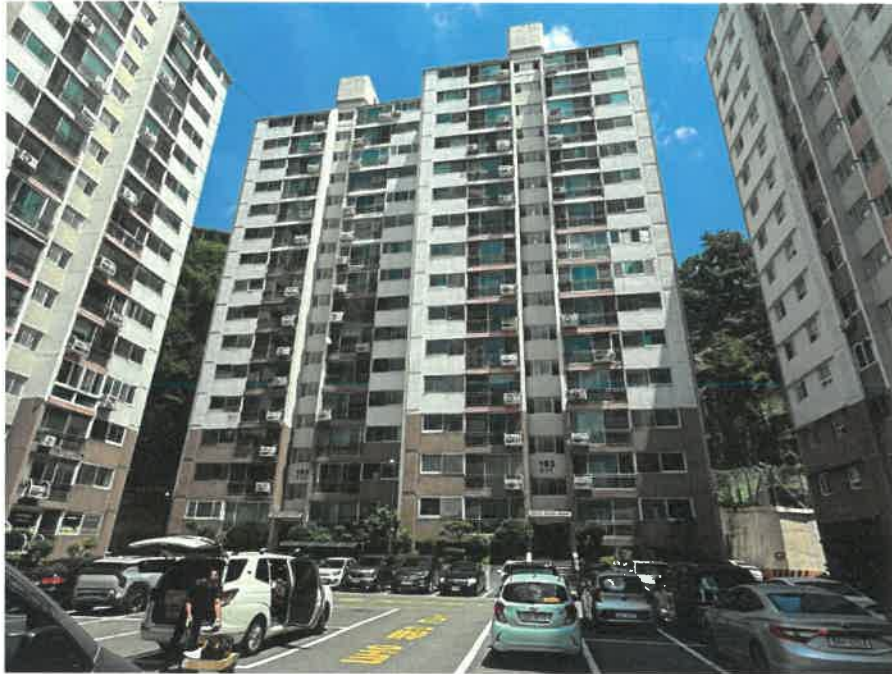
본건 전체 전경
