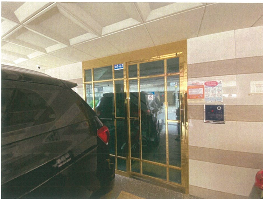
본건 소재 건물 공동출입구
