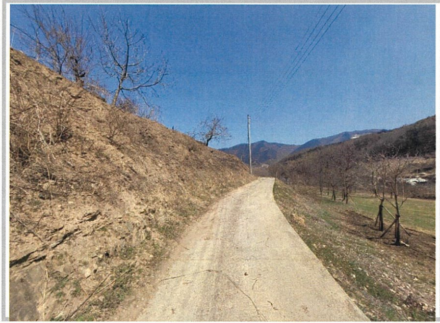
일련번호 2) 인접도로 전경
