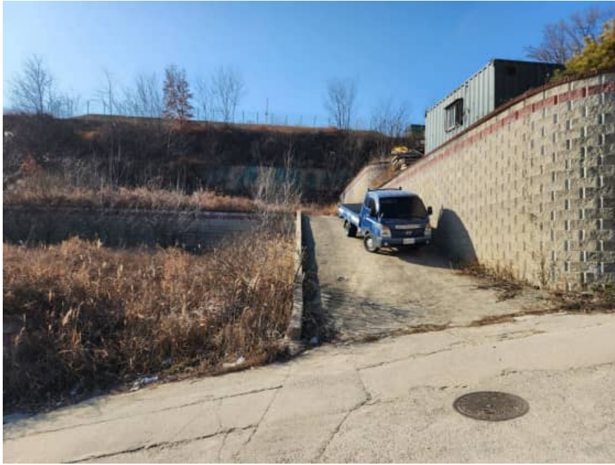
기호 3) 북측과 기호 1) 사이 도로
