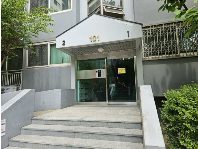
101동 지상 1층 공용 출입구
