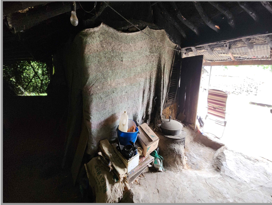
【 본건(기호1-나) 내부 전경 】
