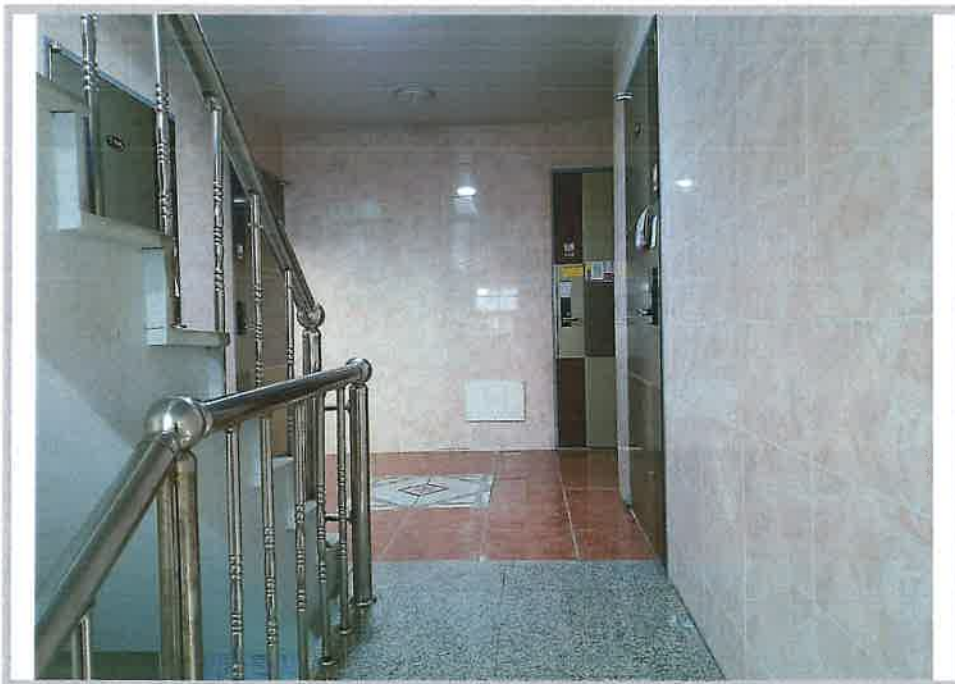
본건(2층 복도 및 계단실)
