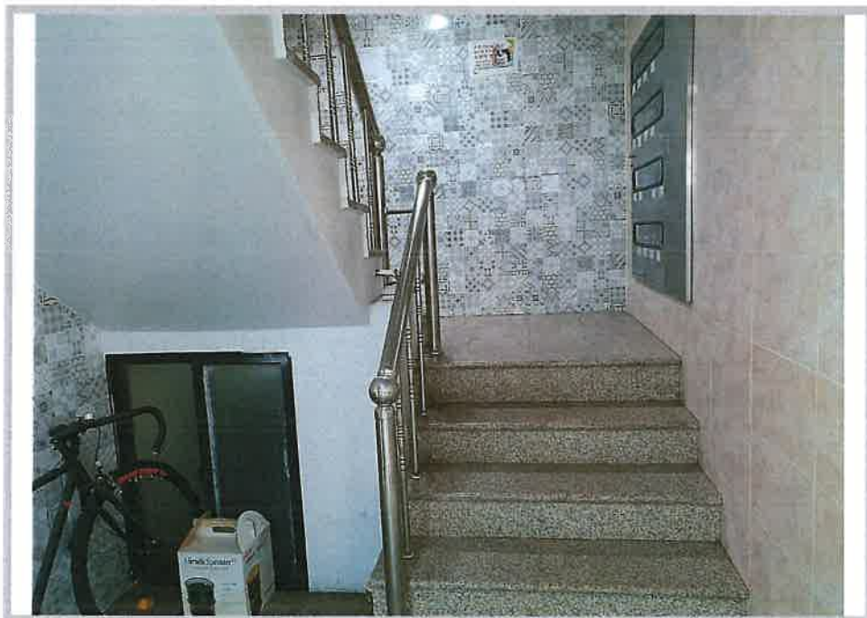
본건(1층 복도 및 계단실)
