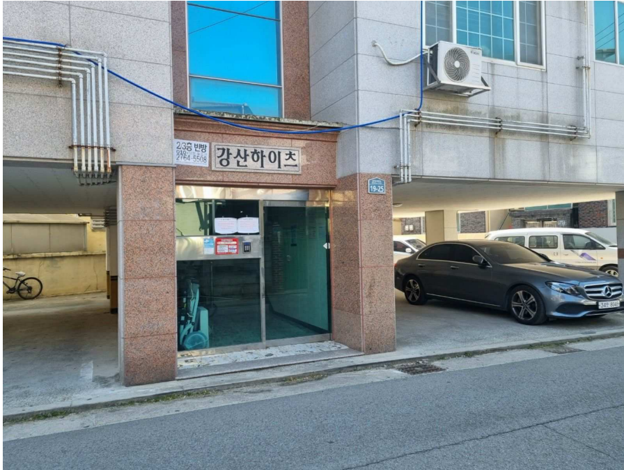
본건 1층 공동출입구 부분
