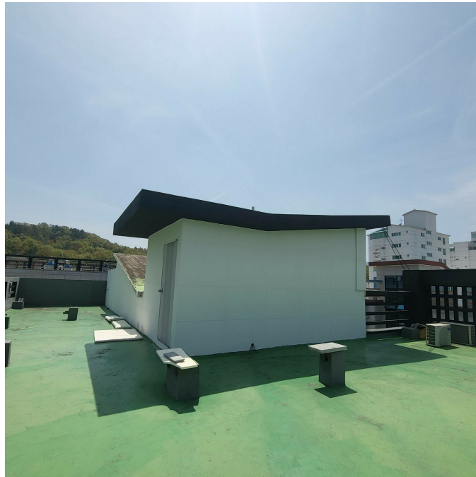
본건 옥상 옥탑, 타워, 칸막이 전경
