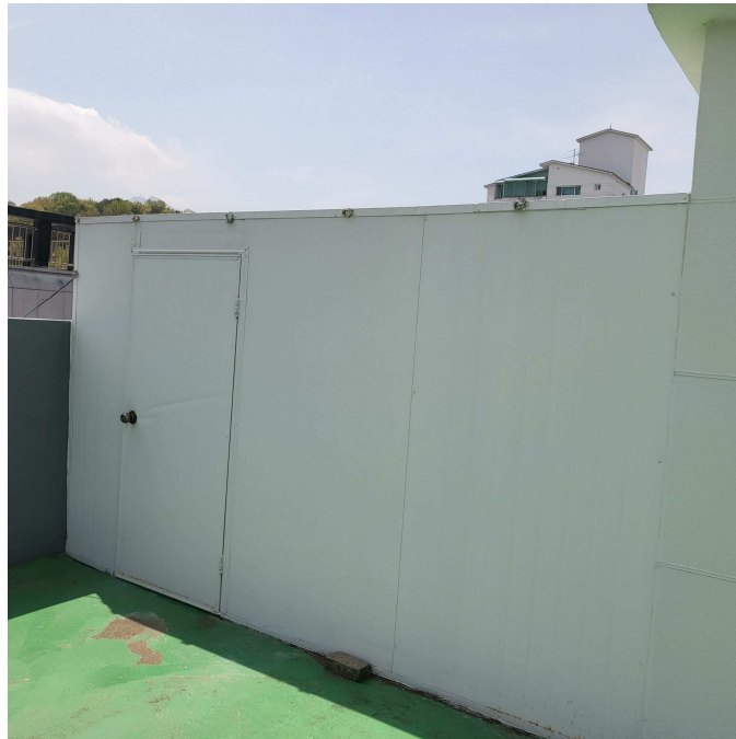
본건 옥상 칸막이 전경
