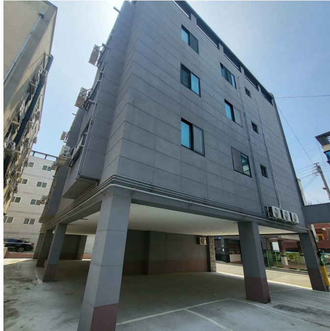
본건 1층 주차장 전경
