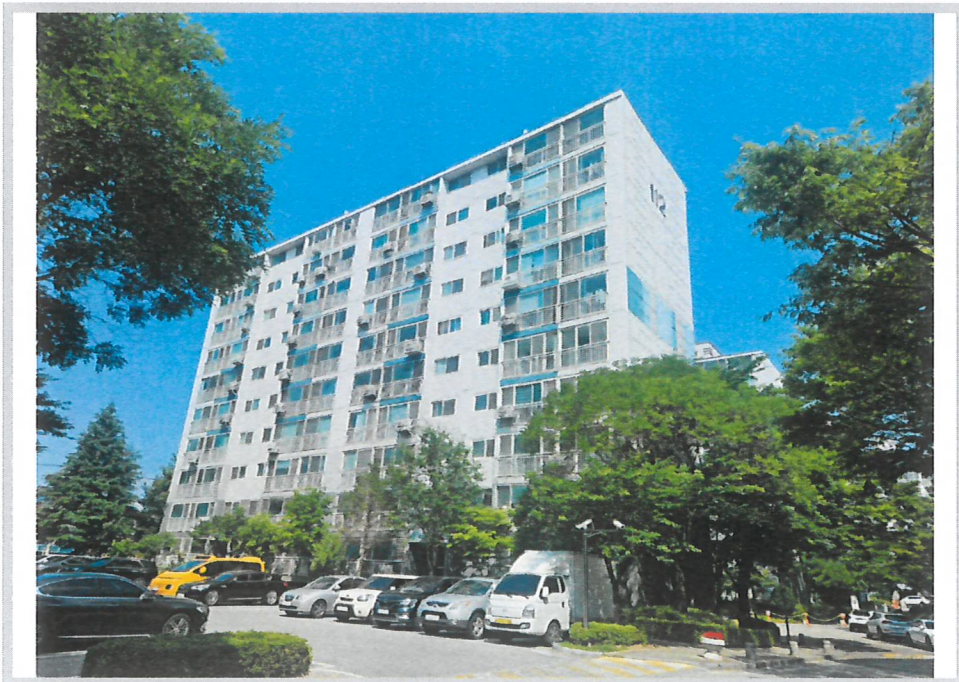
본건 전경 (남동측에서 촬영)
