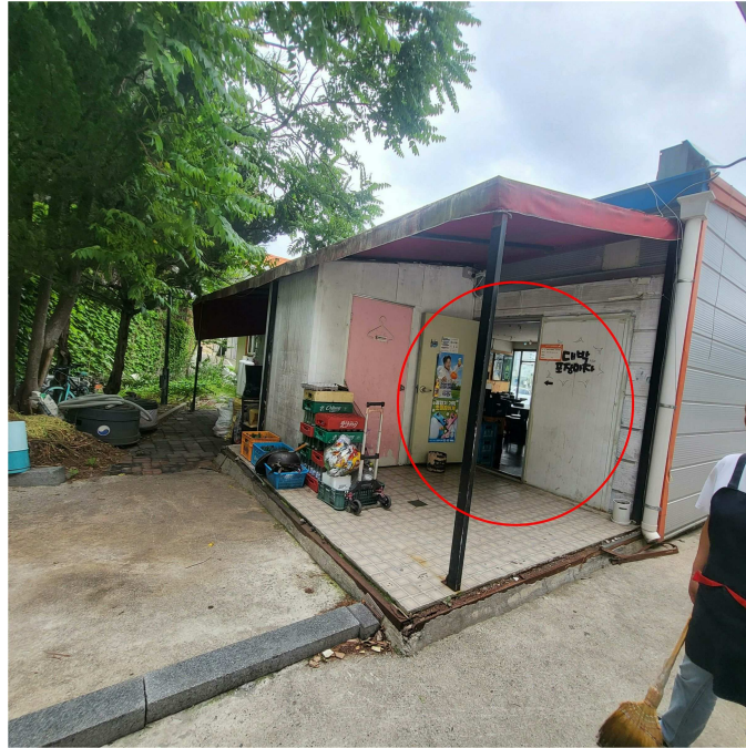
제시외 건물 기호 ㄱ 전경
