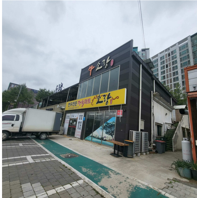
본건 기호2 남동측 전경
