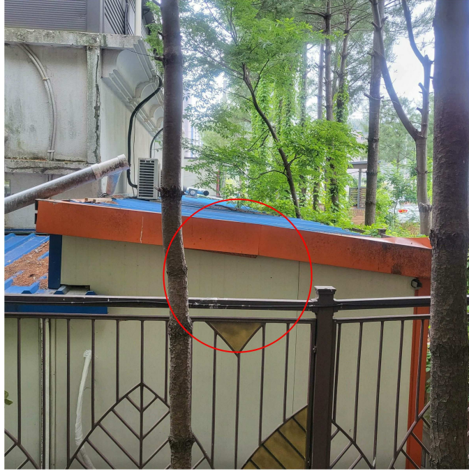
제시외 건물 기호 ㄱ 전경
