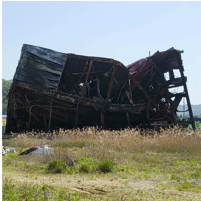
본건 북측 전경
