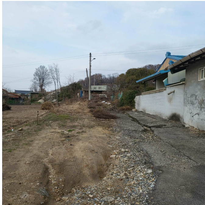
본건 남측 전경
