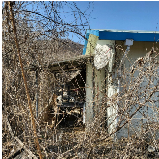
기호2토지상 제시외 건물 ㄴ 창고 전경
