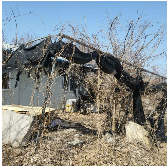
기호2토지상 제시외건물 ㄹ 가작 전경
