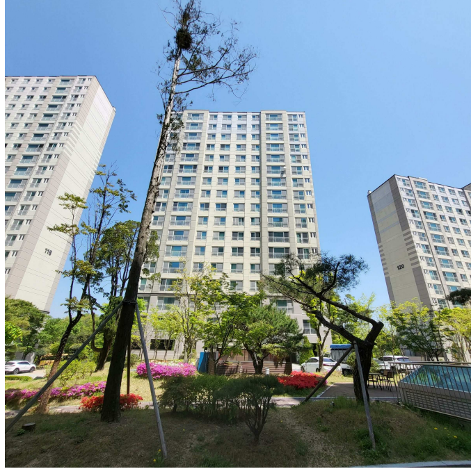
본건 남측 전경
