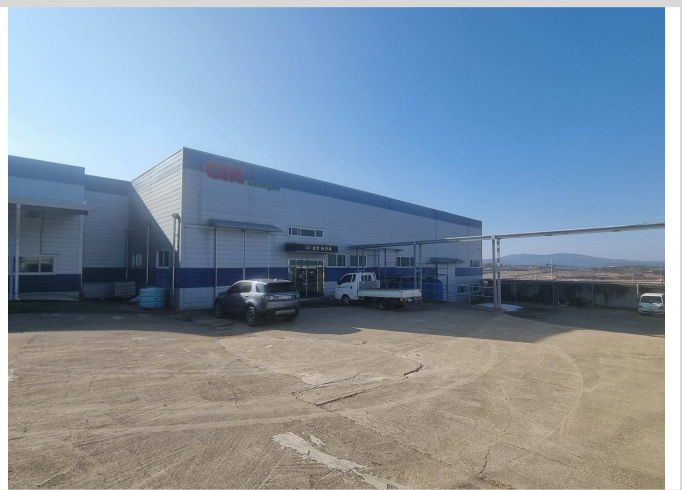
기호 2 건물 증축부분 : 북동측에서 본 전경
