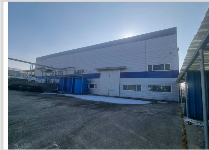
기호 1 건물 : 북동측에서 본 전경
