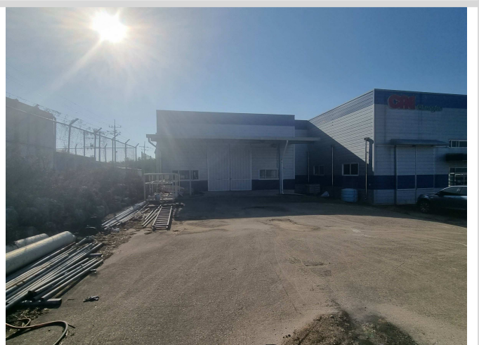
기호 6 건물 : 북동측에서 본 전경
