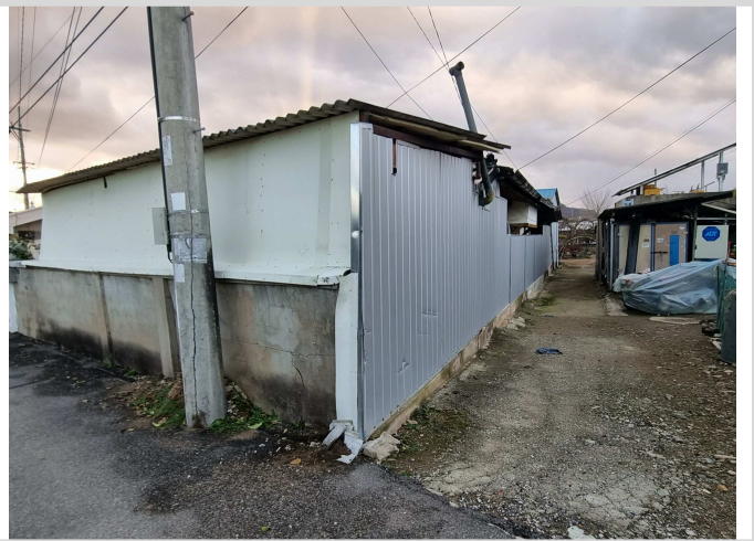
기호 3 남측 도로 및 타인점유부분
