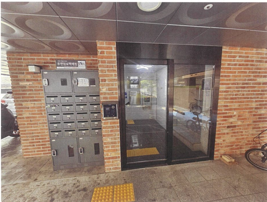
본건 소재 건물 공동출입구
