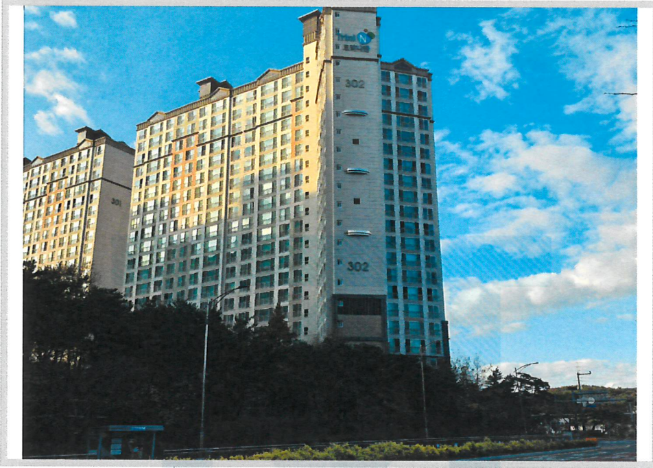
본건 전경(남동측에서 촬영)
