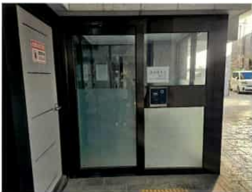
편건이 속한 건물 공동 출입문
