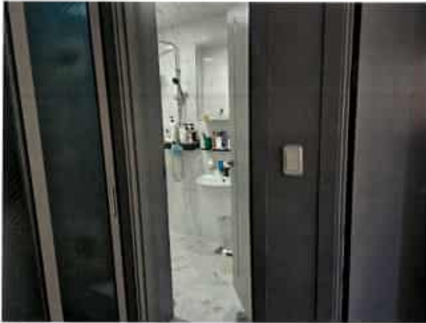
본건 제시외건물 ㉠ 화장실
