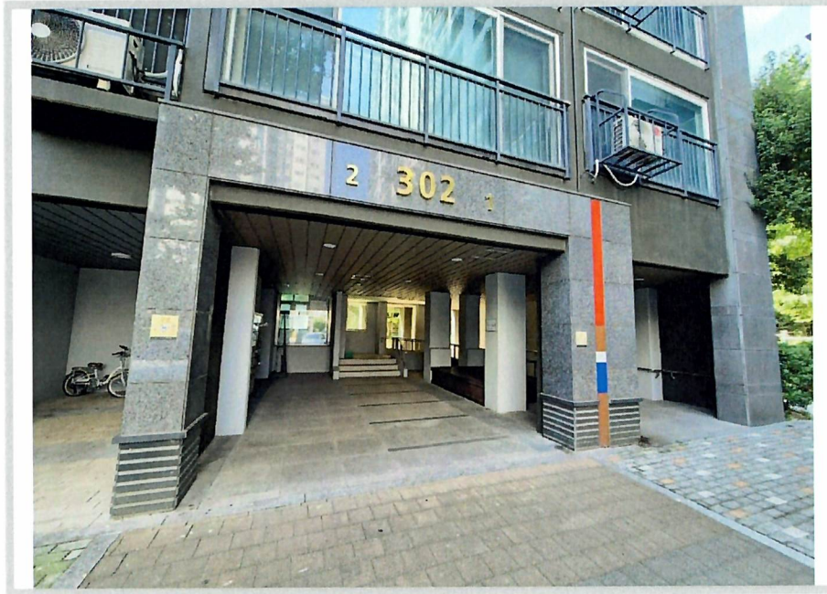
본건 1층 출입구
