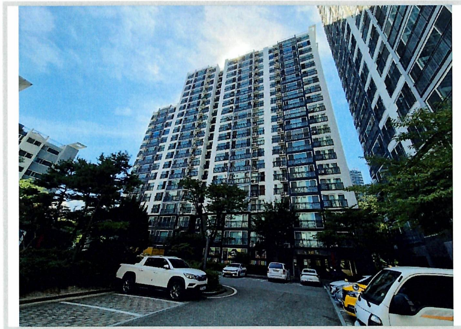
본건동 전경(동측에서 촬영)
