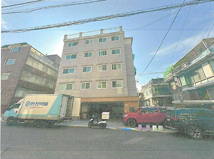
<본건 건물 전경>
