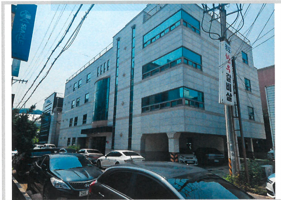
본건 전경(남동측에서 촬영)
