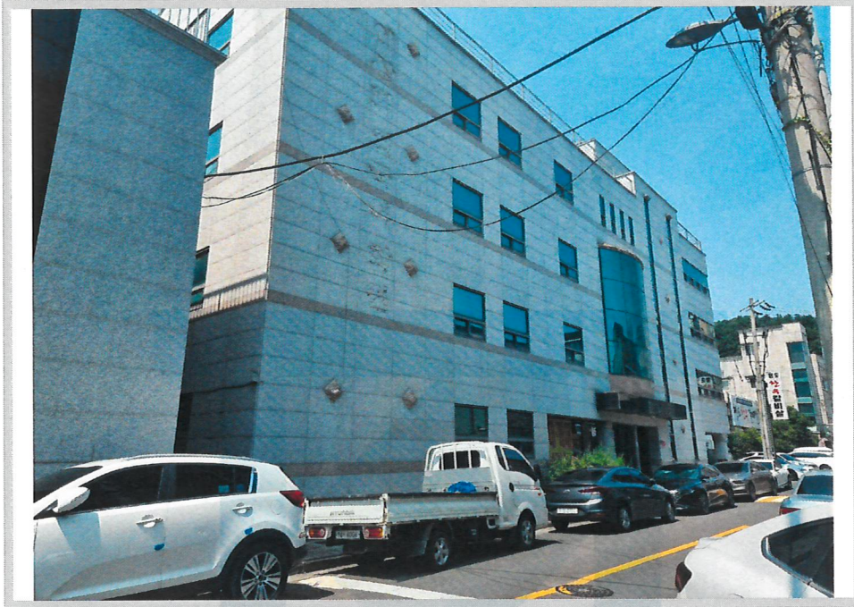
본건 전경(남서측에서 촬영)
