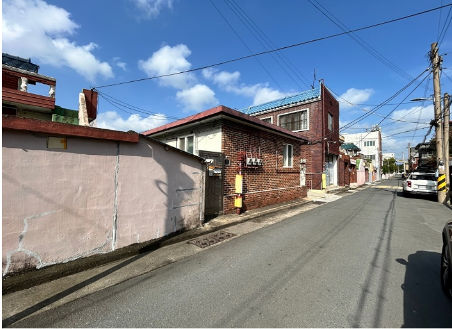
[ 본건 남동측 전경 ]
