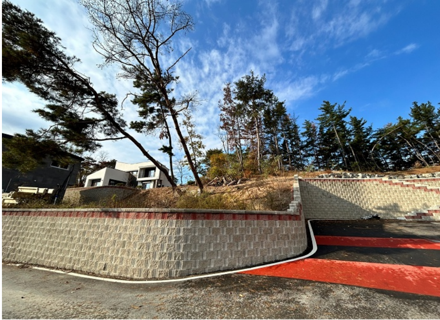
[ 기호 5) 북동측 전경 ]
