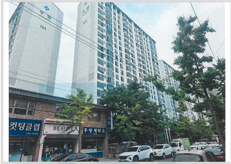
본건 전경(남동측에서 촬영)
