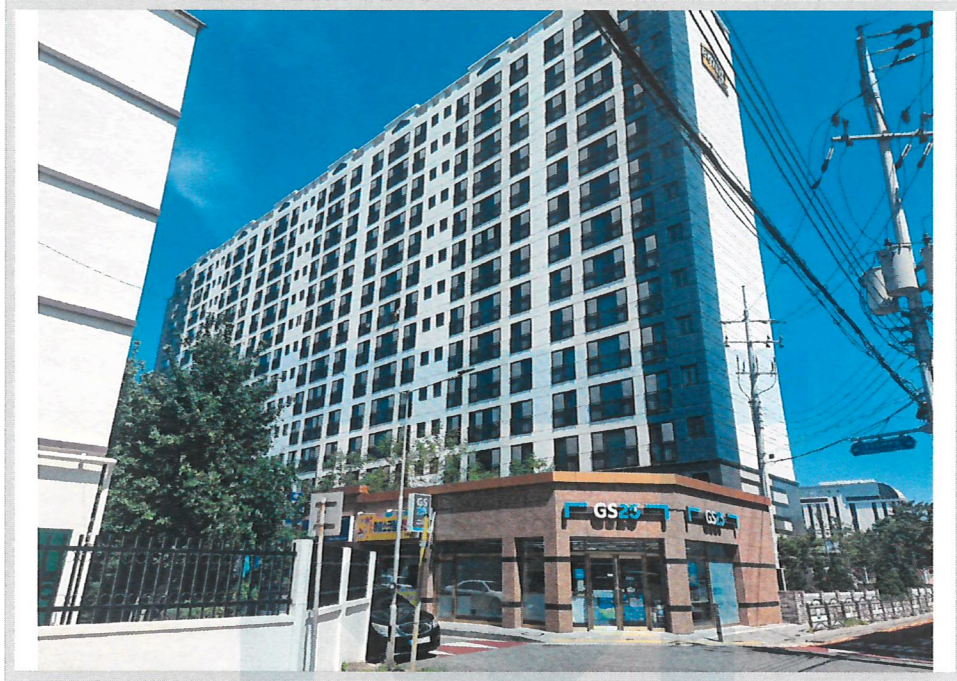
본건 전경(남동측에서 촬영)
