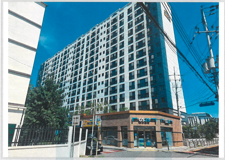
본건 전경(남동측에서 촬영)
