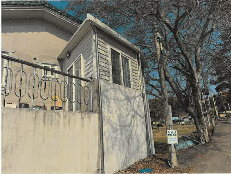
제시외 건물 ㄷ (2층 소재부분)
