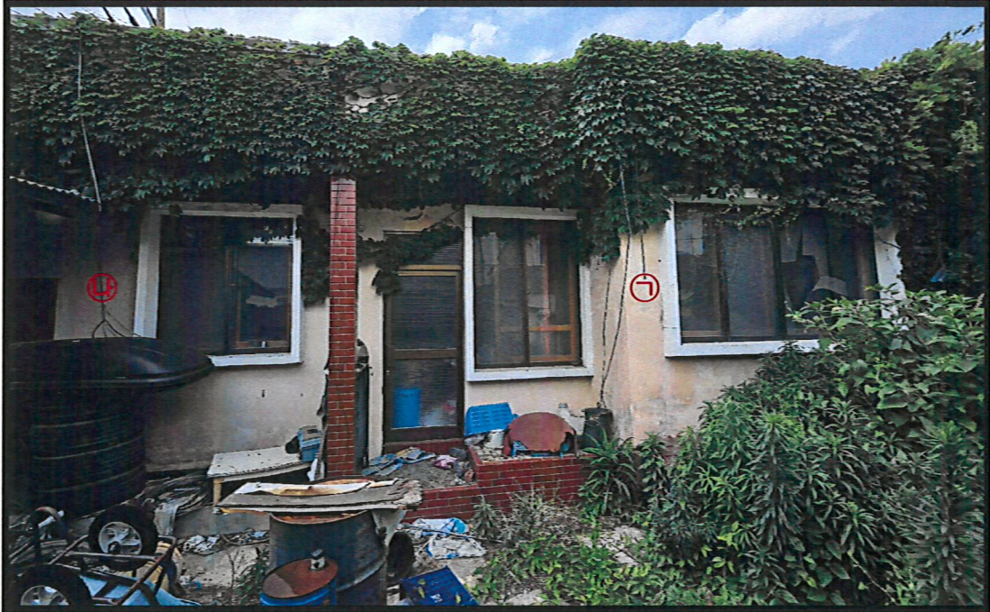
<본건 일련번호㉠ 및 제시외건물㉡ 전경>
