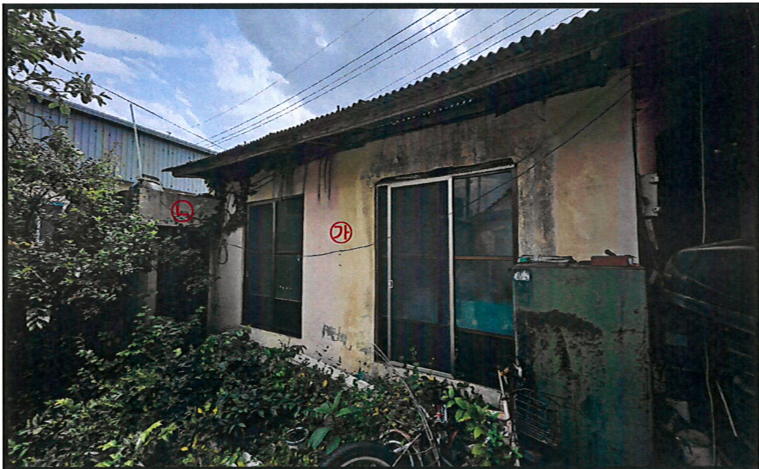
<본건 일련번호㉠ 및 제시외건물㉡ 전경>
