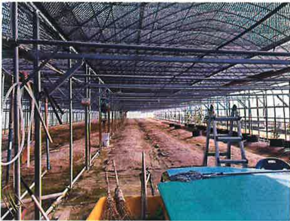
제시외건물(기호 ㄴ) - 내부전경
