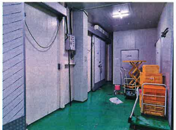
본건 건물(1층 내부)1
