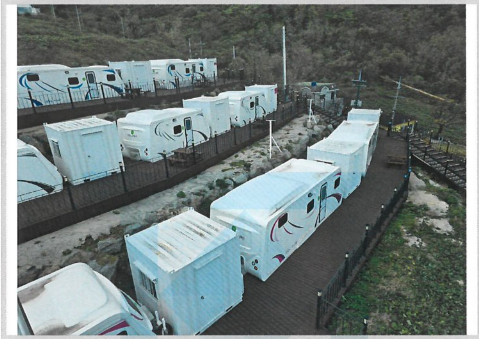
기호(5, 16) 및 지상 건물 전경(북동측에서 촬영)
