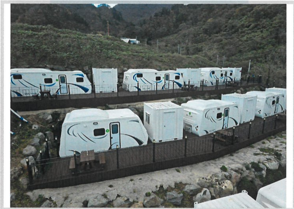
기호(5,16) 및 지상 건물 전경(북동측에서 촬영)
