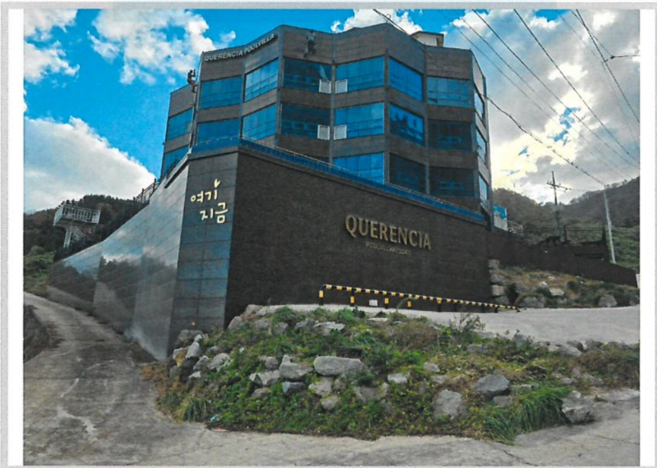
기호(1,9,10) 전경(북서측에서 촬영)
