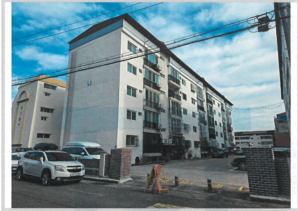
본건 전경(남서측에서 촬영)
