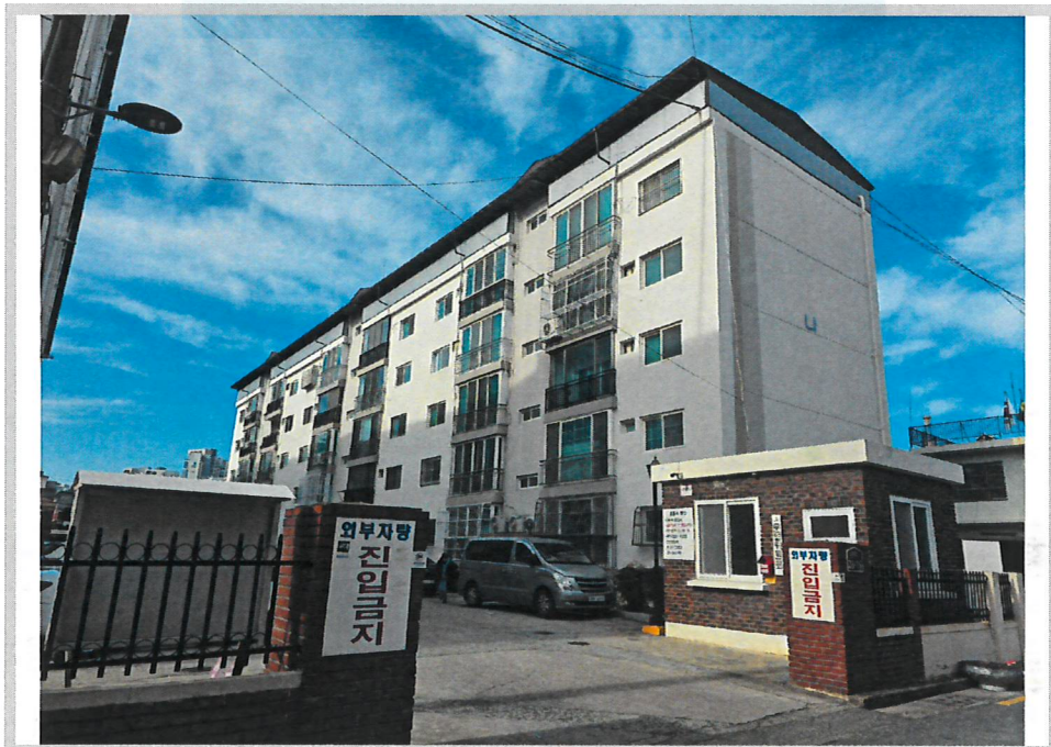
본건 전경(남동측에서 촬영)
