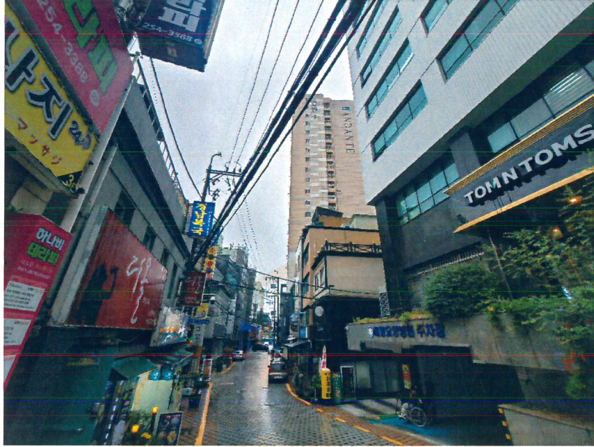
프리미엄안단테 전경 및 주위전경(북측에서 촬영)
