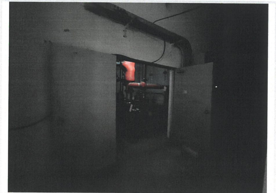
본건 건물 지하
