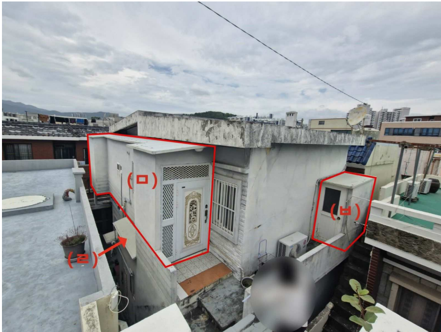
본건건물2층 전경 및 제시외건물(ㄹ,ㄴ,ㄷ)
