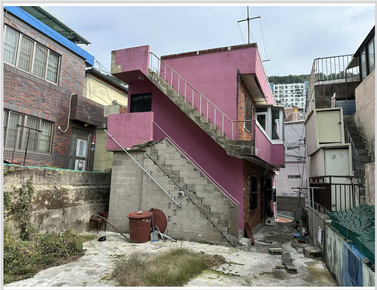
본건 (1,2) 전경 및 제시외건물
