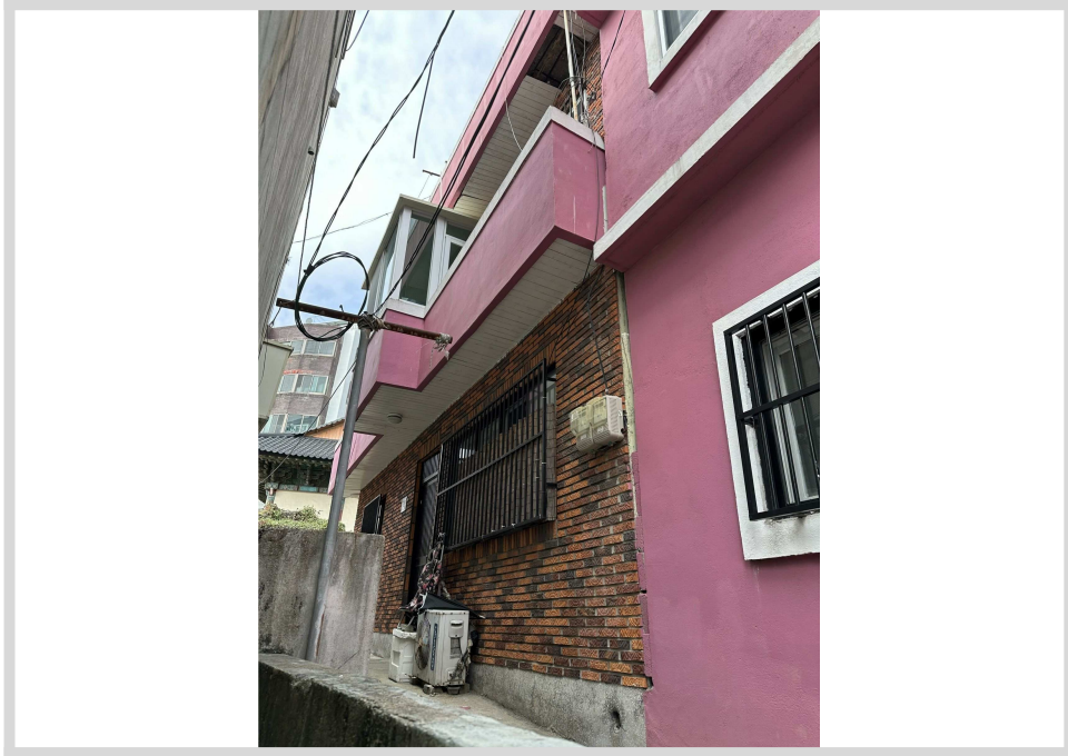
본건 (1,2) 전경 및 제시외건물
