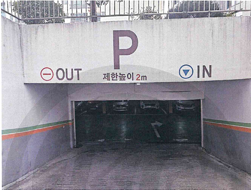
본건물내 주차장 입구 전경
