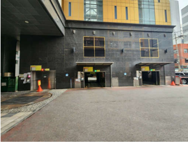
기계식 주차장 진출입구
