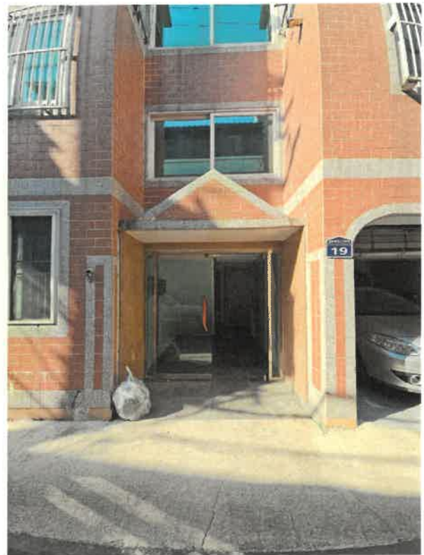
본건 1층 출입문
