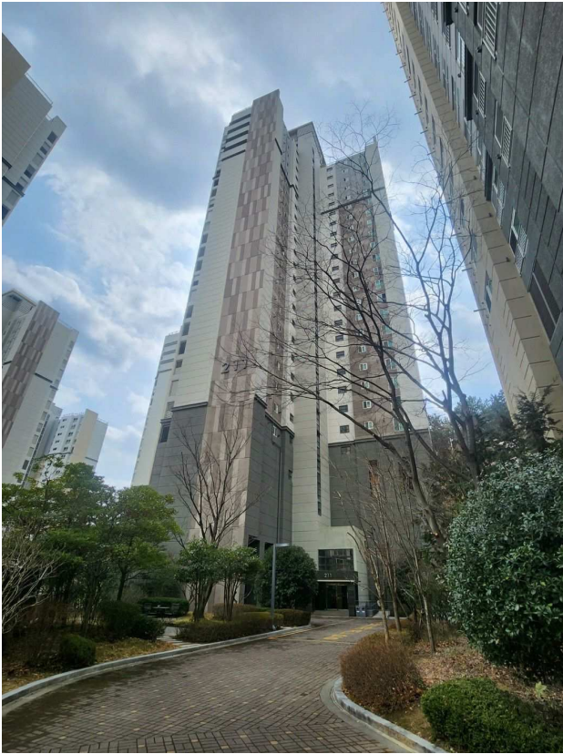
211동 단지 내 전체 전경
