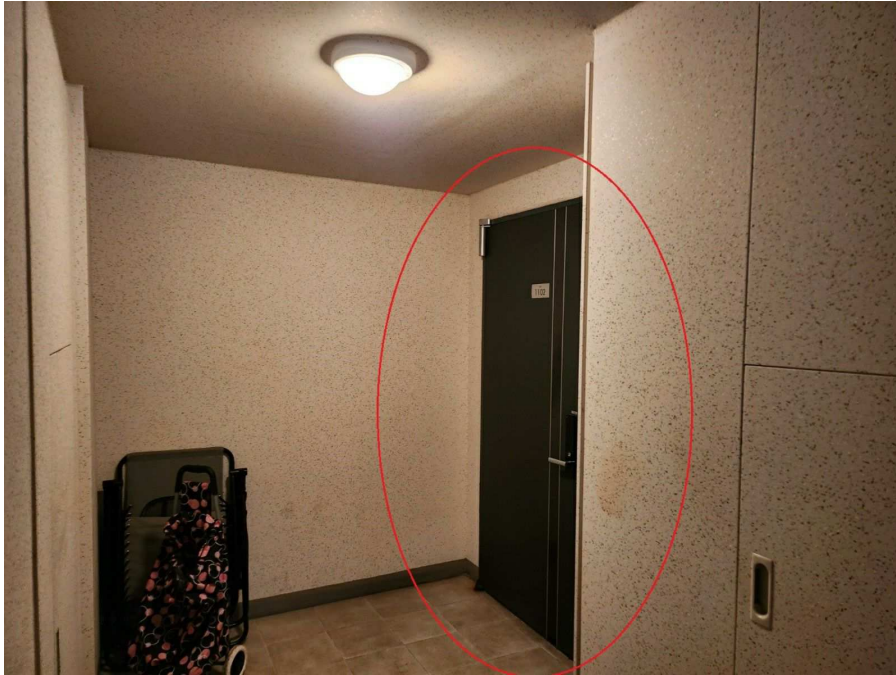
211동 11층 1102호 출입전경
