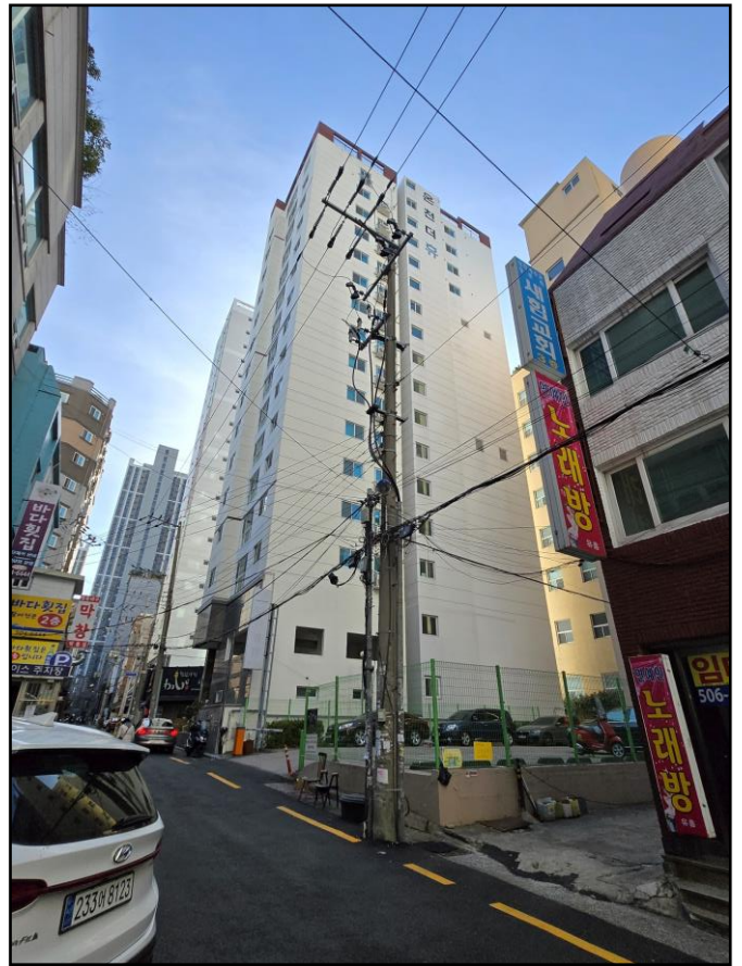
[본건 후면 전경 (북동 → 남서)]
