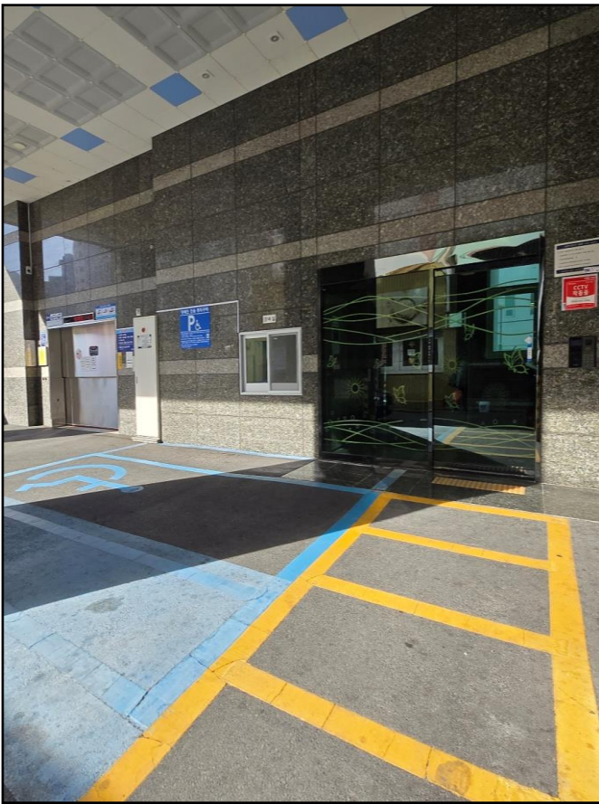
[본건 공동현관 및 기계식주차시설]
