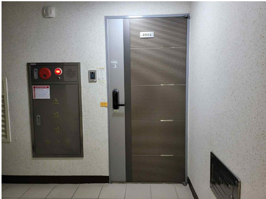
본건 출입문 전경 [25층 2504호]
