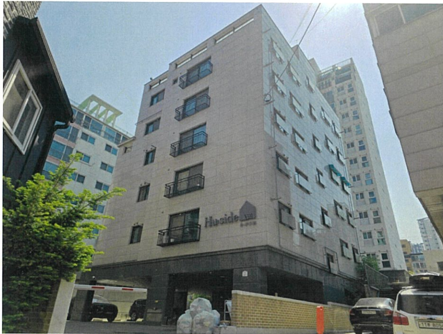
본건 건물 전경
