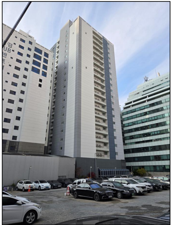
[본건 전경 (남동 → 북서)]
