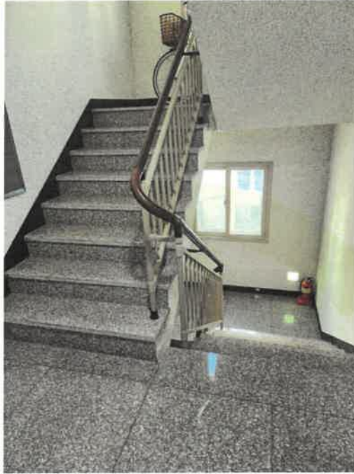
각층 공동비상계단 전경
