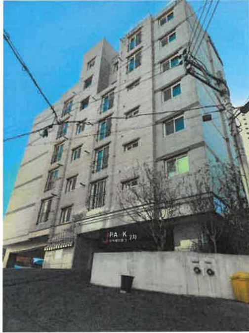
본건 외부전경(본건 북서측 도로변에서 촬영)
