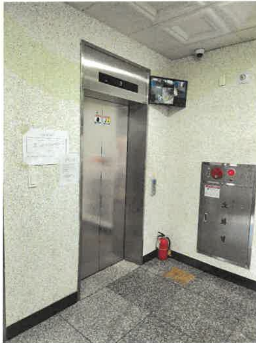
본건1층 공동엘리베이터 전경
