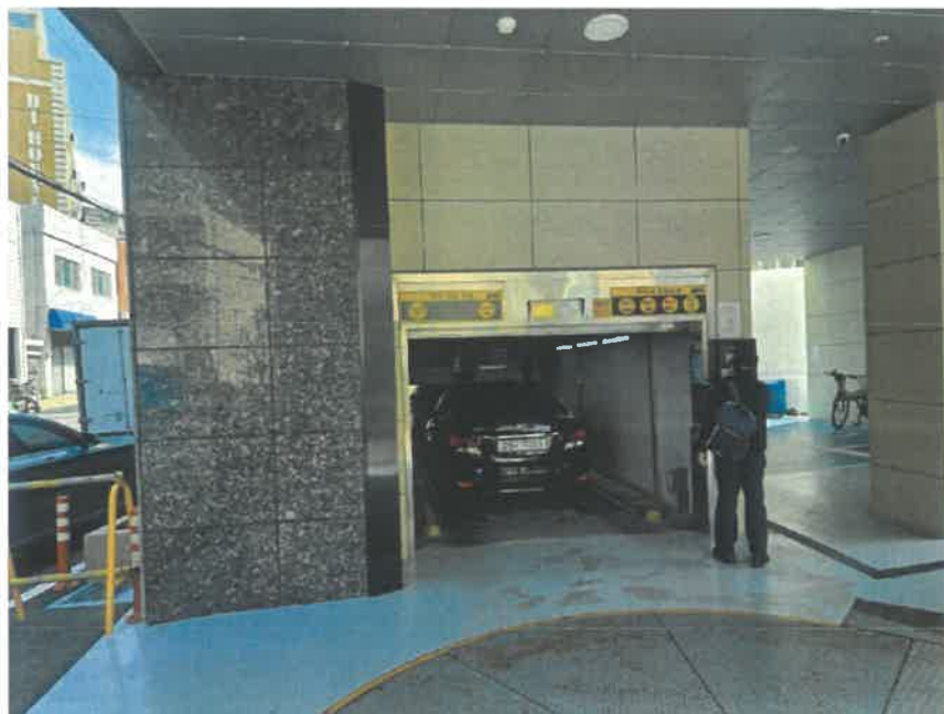
본건 주차타워 출입구
