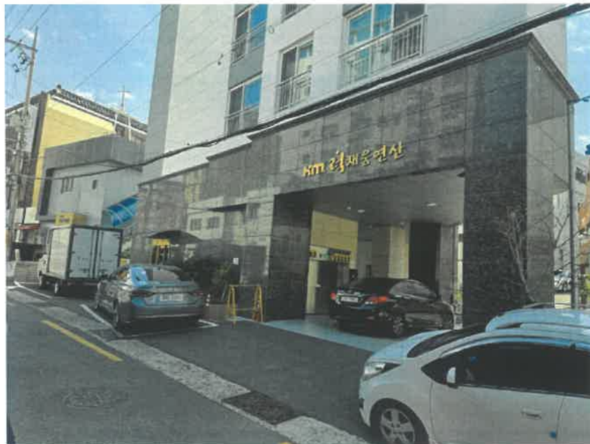
본건 1층 출입구
